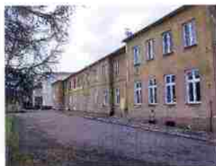
budynek od frontu
