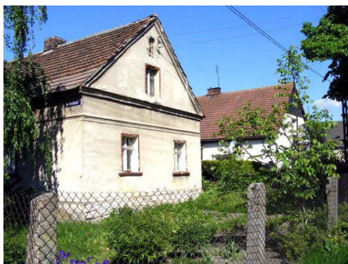
Ryc. 1 Zabudowa na ulicy Brzozowej
