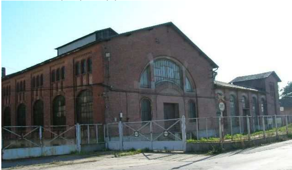
Fot. nr 6 Zabudowa przemysłowa byłej cementowni Grundmann
