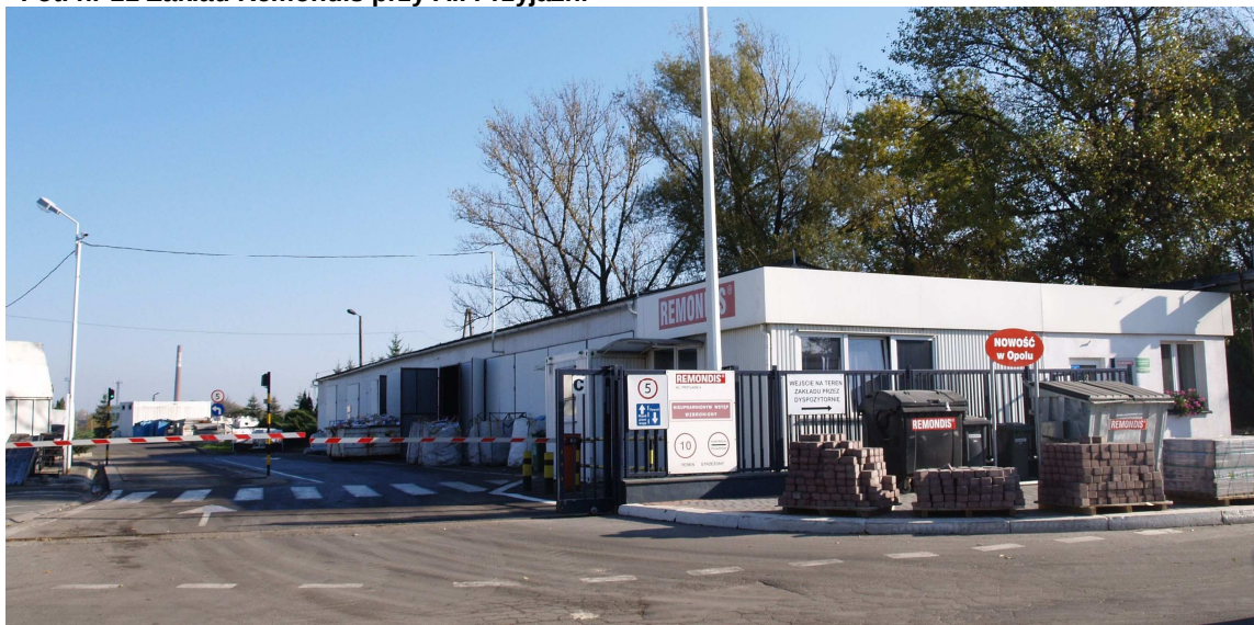
Fot. nr 11 Zakład Remondis przy Al. Przyjaźni
