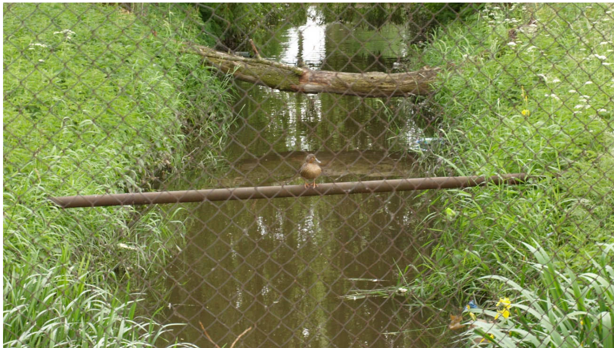
Fot. nr 12 Widok na fragment koryta Maliny.
