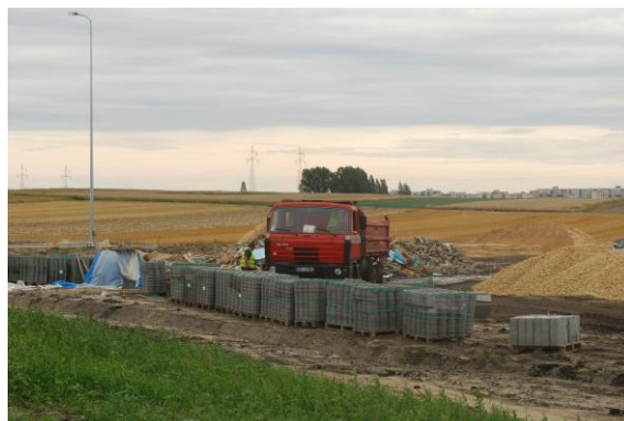
Fotografia 4 Ścieżka pieszo-rowerowa w budowie
