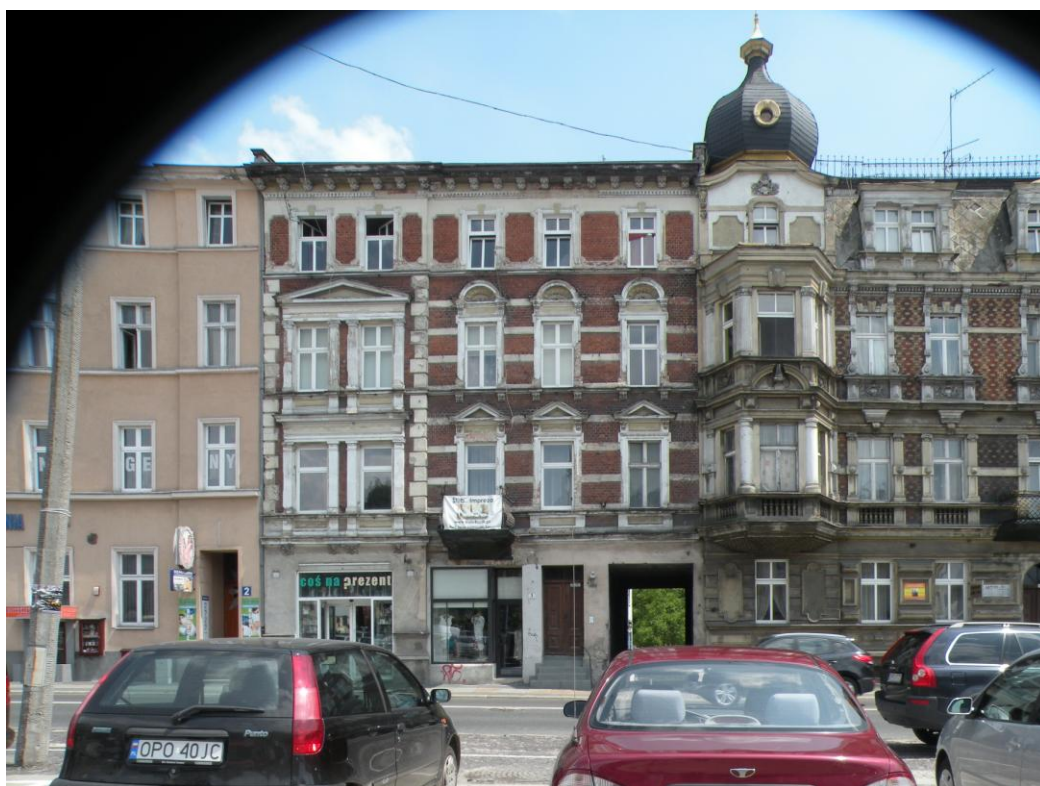
il. 20. kamienice z XIX wieku w pierzei wschodniej Placu Kopernika – sugerowana w opracowaniu linia zabudowy pierzei północnej Placu (pomiędzy budynkiem nowym i dawnym), fot. D. Kłosek-Kozłowska, 2013
