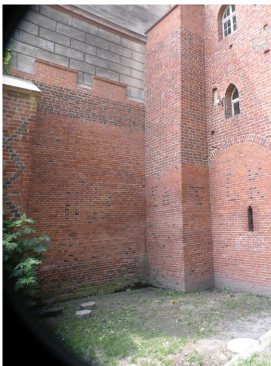
il. 17. Wieża zamku górnego w linii murów obronnych z widocznym przejściem przez fosę miejską, fot. D. Kłosek-Kozłowska, 2013.
